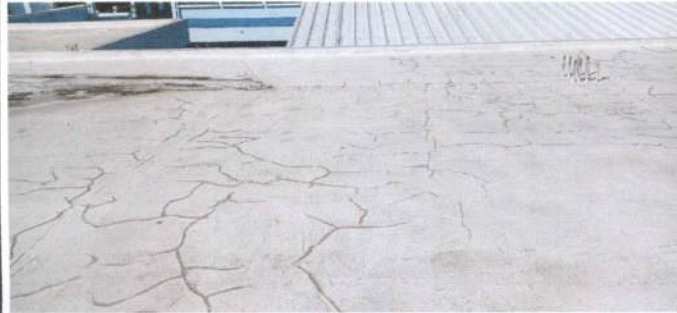
Foto 1: Impermeabilización de lozas ✓
